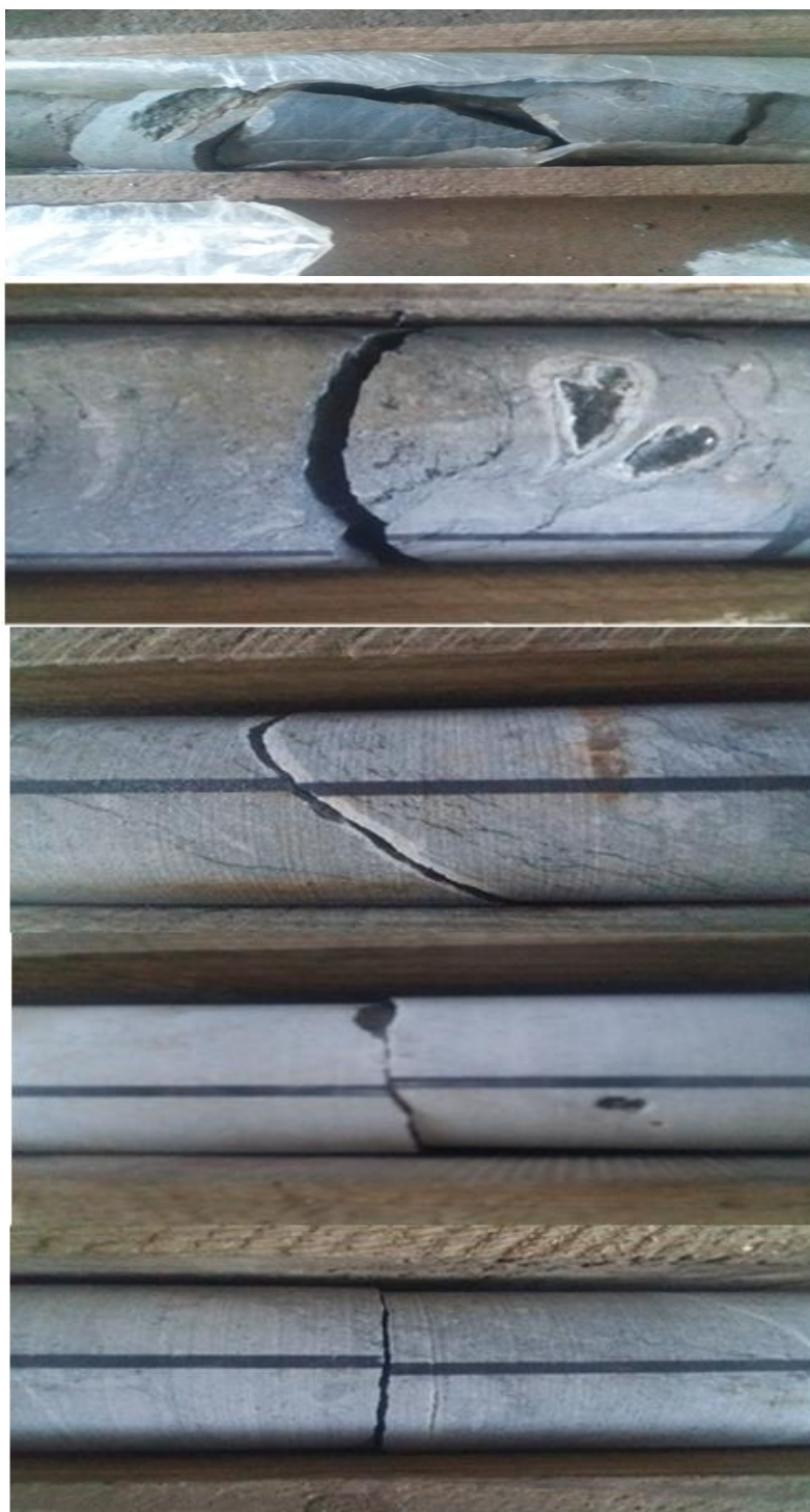
Рисунок 7 – Механические трещины, образовавшие во время бурения
